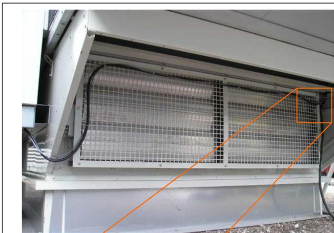
Ensuite, fixer les 2 câbles sur la grille de la costière d'extraction et insérez-les dans le tableau électrique du rooftop
