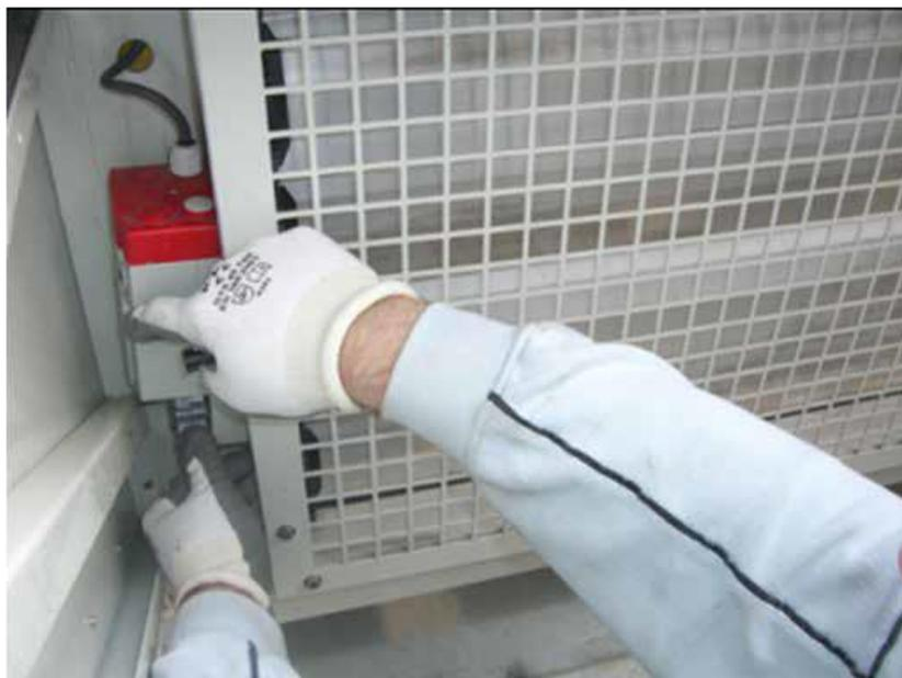
Et ne raccordez pas le servomoteur au rooftop.
