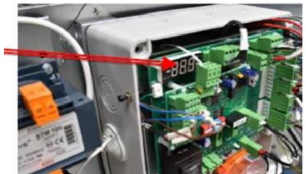
**Regolazione della potenza Bassa/Alta (Lo/Hi) usando dell’analizzatore di combustione.**
