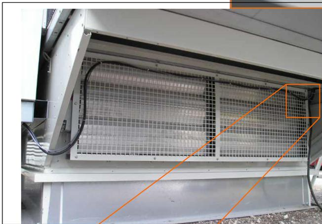
Después, fije los 2 cables en la rejilla de la bancada extracción e introdúzcalos en el panel eléctrico de la unidad rooftop.
