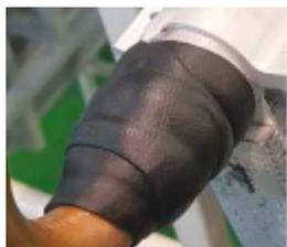
Pour les échangeurs thermiques à micro-canaux, le raccordement entre la batterie et le circuit s'effectue à l'aide d'une soudure cuivre/aluminium. Ce raccordement est protégé contre la corrosion galvanique par une résine spéciale encapsulée dans une manchette réalisée avec un type de bitume.
