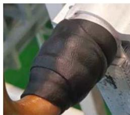
Pour les échangeurs thermiques à micro-canaux, le raccordement entre la batterie et le circuit s'effectue à l'aide d'une soudure cuivre/aluminium. Ce raccordement est protégé contre la corrosion galvanique par une résine spéciale encapsulée dans une manchette réalisée avec un type de bitume.
