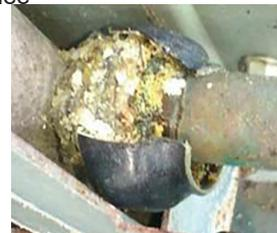
Corrosion galvanique sous la gaine en plastique.
