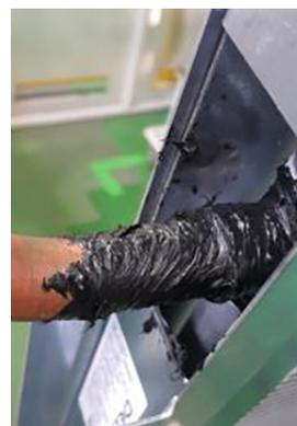
Ne pas hésiter à ajouter du mastic au polyuréthane afin de garantir une couverture complète de la zone.
