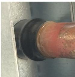
Pour les échangeurs thermiques à micro-canaux, le raccordement entre la batterie et le circuit s'effectue à l'aide d'une soudure cuivre/aluminium. Ce raccordement est protégé contre la corrosion galvanique par une résine spéciale encapsulée dans une gaine thermo-rétractible.
